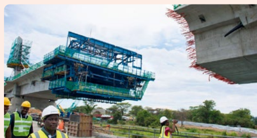
Bau einer Autobahnbrücke
