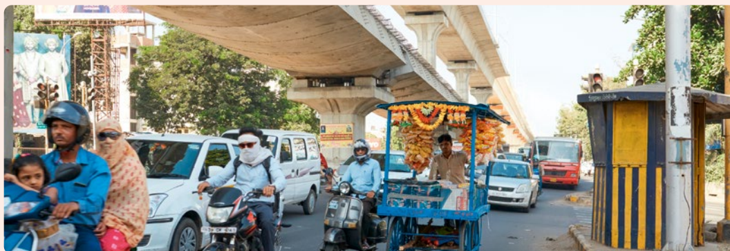
Bau der Hochbahn in Nagpur, Indien
