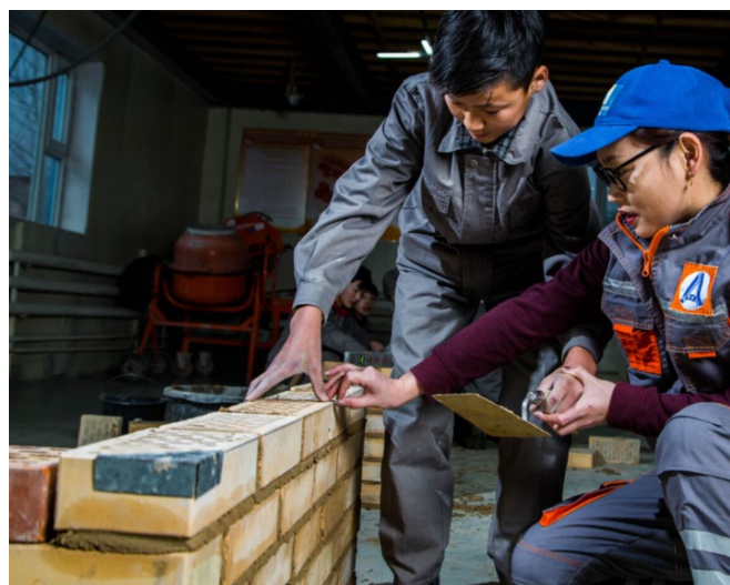
Zwei Facharbeiterinnen begutachten ein Mauerwerk.
