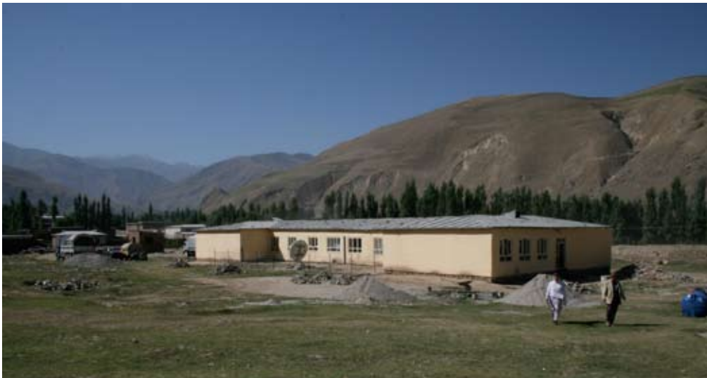
Hier wird fleißig gepaukt: Teacher Training College in Faizabad. Das neue TTC für 900 Studenten ist bereits im Bau. (F: DED)
